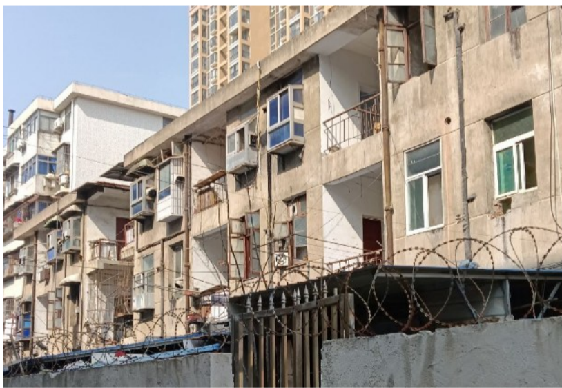
祁家山新村56号改造前。
