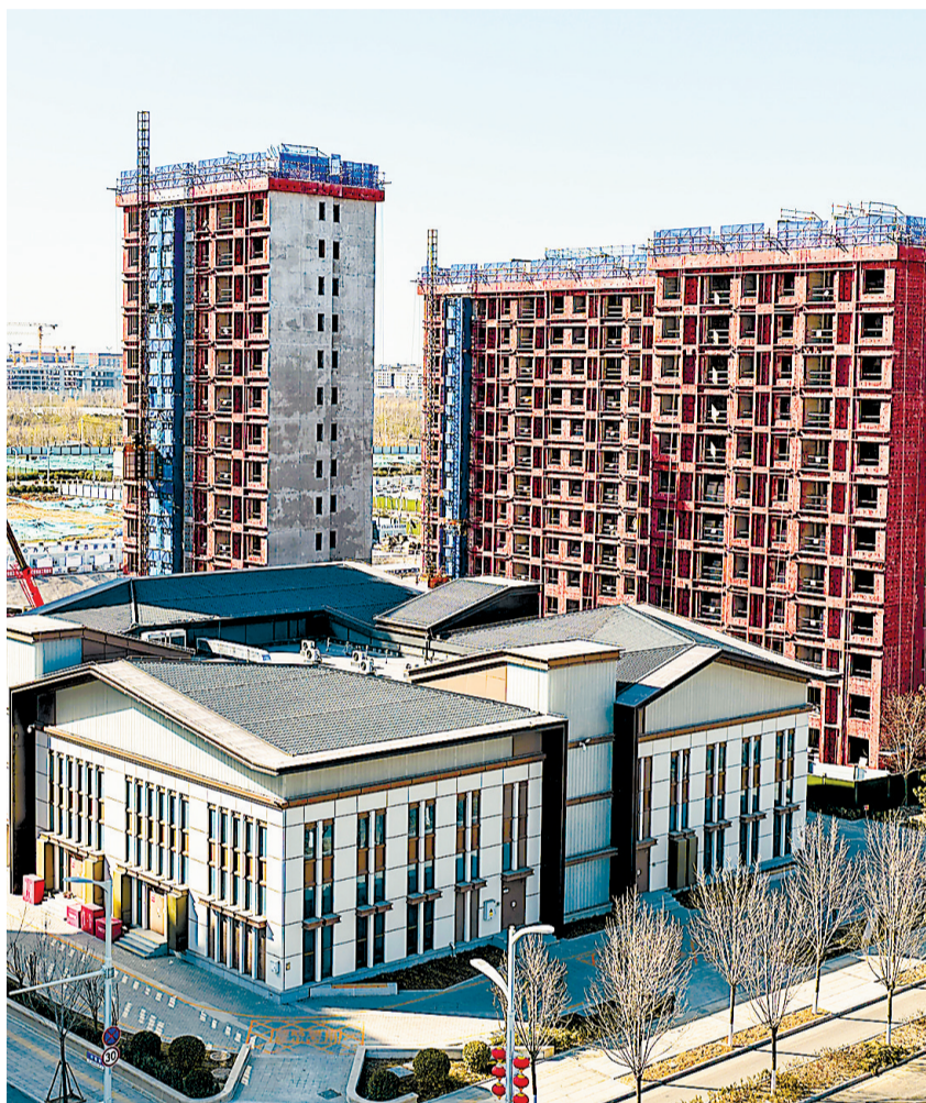
河北雄安新区“鸿渐之翼”——鸿渐110千伏变电站外景。 新华社发
