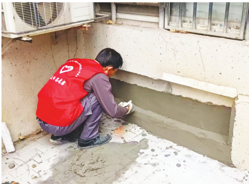
世茂物业工作人员为金江公寓一楼修补阳台裂缝。
