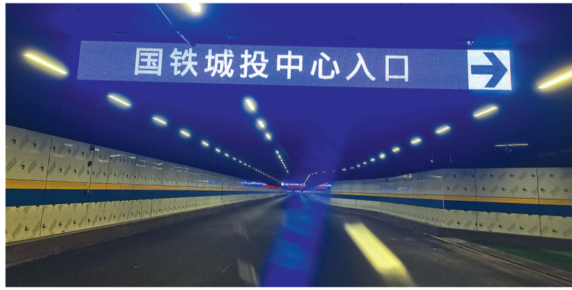
地下环路多个出入口串联周边写字楼、小区、商场的地下车库。
