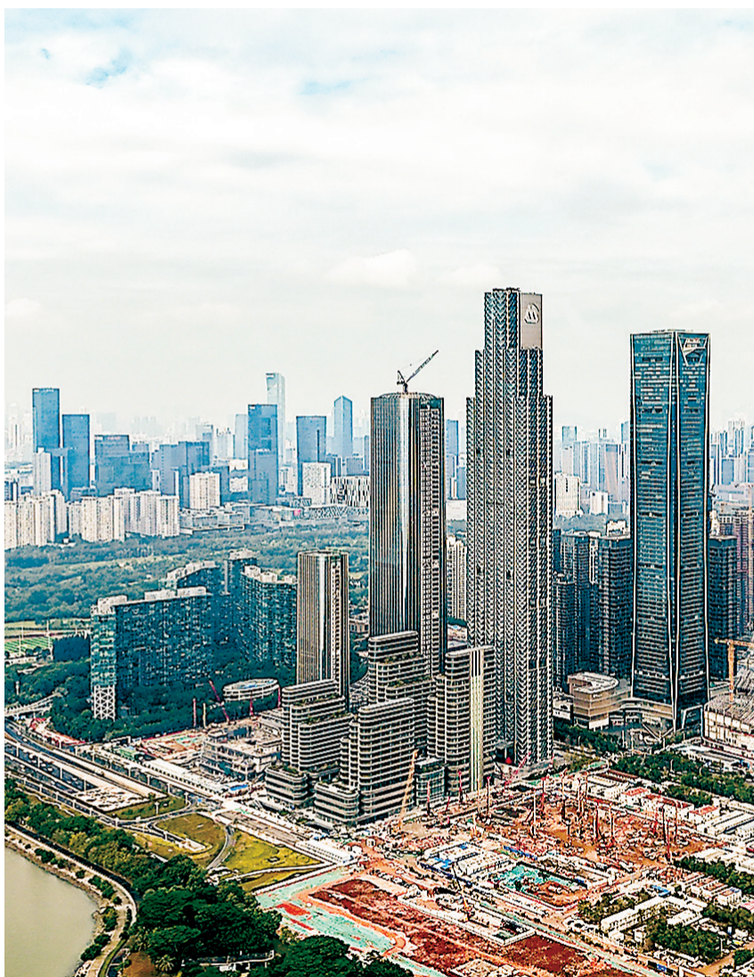
建设中的深圳湾超级总部基地。
