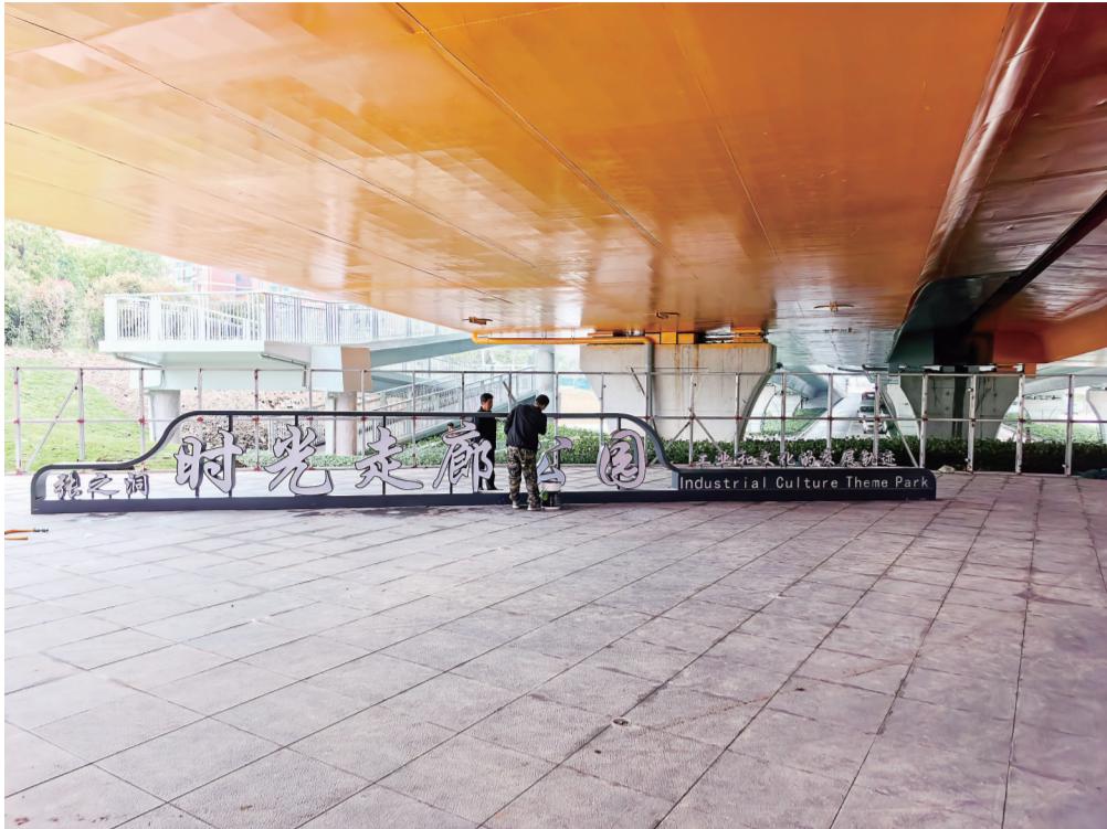
张之洞时光走廊公园正在建设中。
