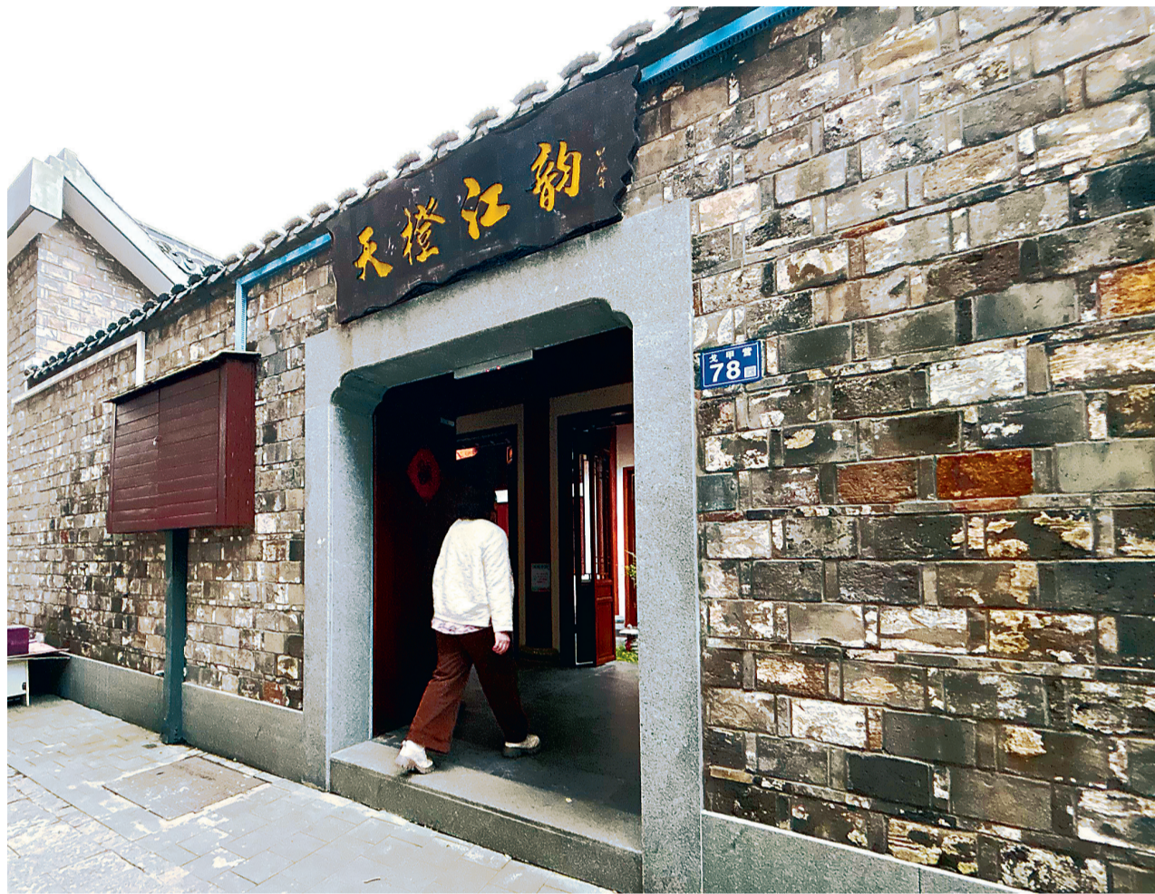
房屋改造保留外墙青砖原貌。
