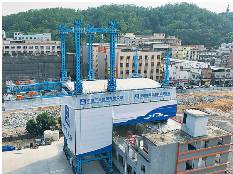
“城市更新机”正在广东虎门衣流时尚园项目投用。
