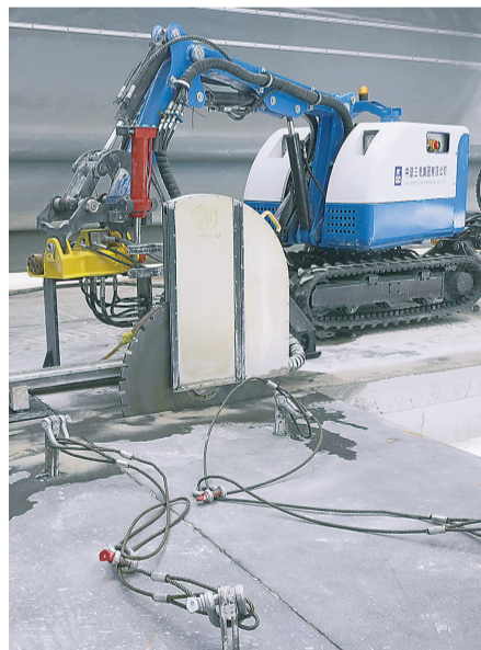
机器人正在使用切割机切割楼板。
