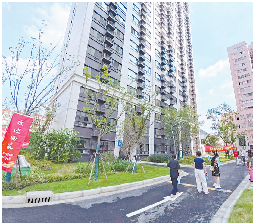
居民走在新建成的上海市静安区谈家桥小区内。
