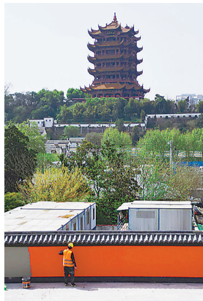
黄鹤楼前“新红墙”施工现场。
