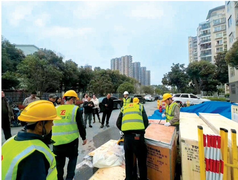
工作人员进行现场施工。
