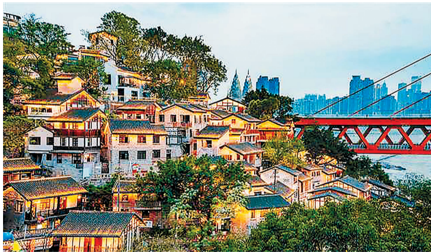
重庆南岸下浩里城市更新项目。
