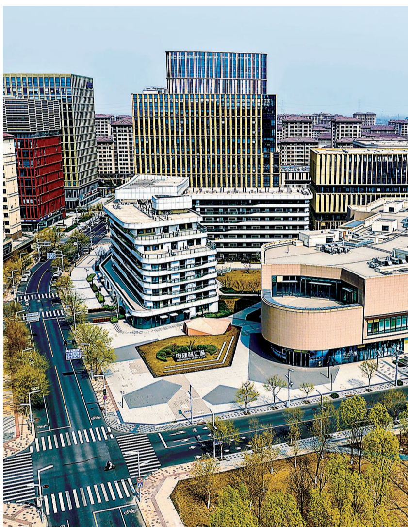
各地探索将装配式建造技术融入民生安居与工业生产。 新华社发
