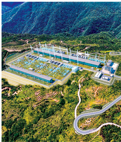
浙江特高压交流环网工程温州变电站效果图。
