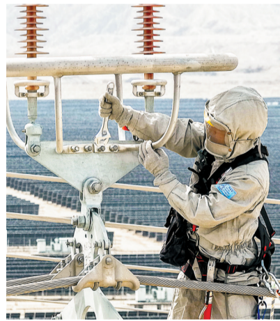
环塔里木盆地750千伏输电环网成功实施首次带电作业。
