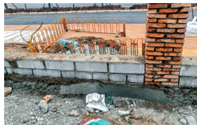
124小区院墙施工中。
