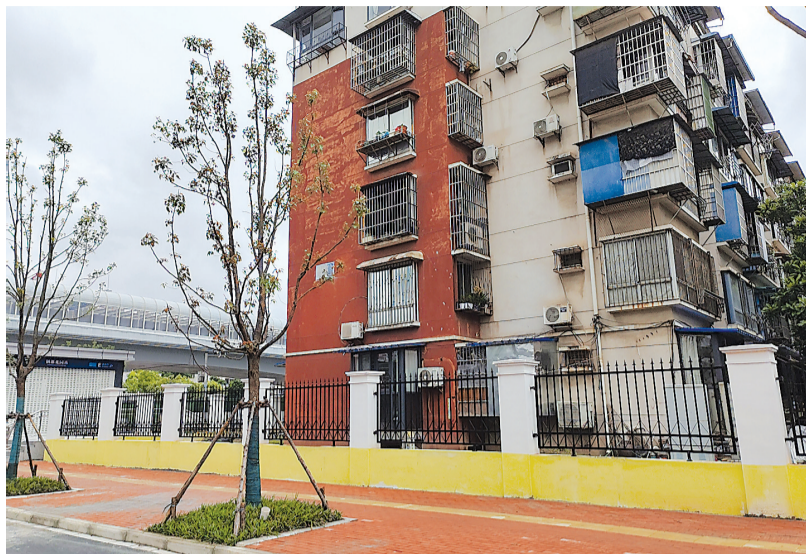
124小区院墙恢复后。
