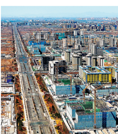
雄安新区第五组团建设现场。
