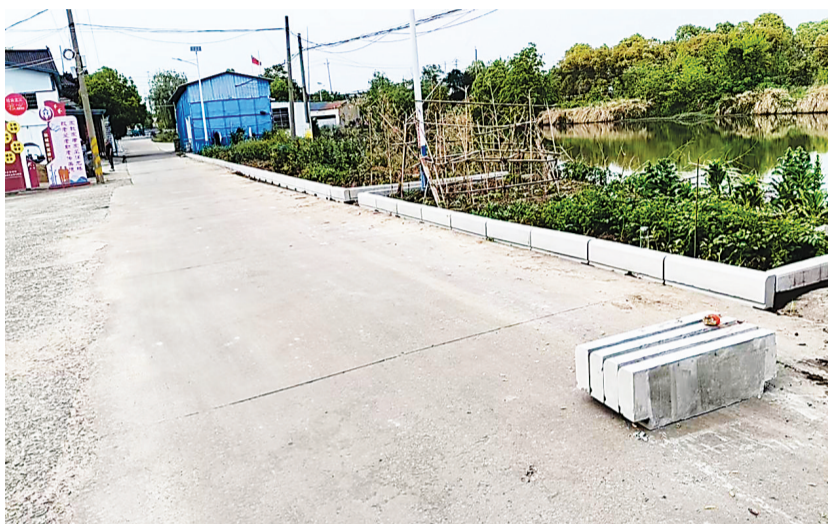
硬化修复通湾道路。
