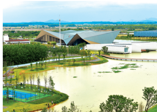
已经建成竣工的沉湖国际小镇一期项目。
