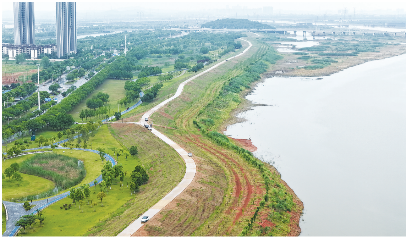
通顺河边,新合垸堤整修一新。
