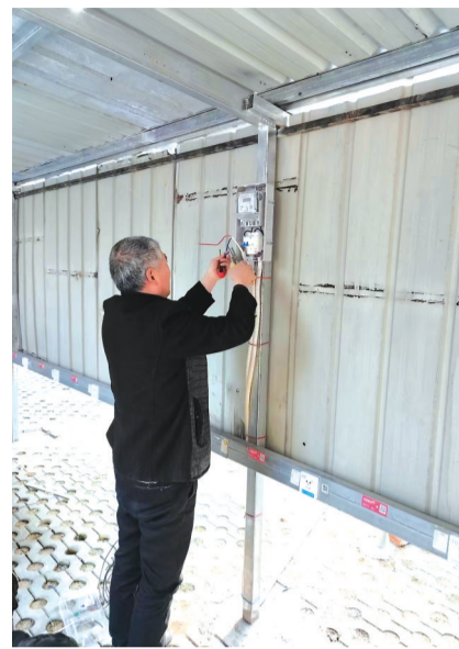
电工师傅安装固定充电桩。
