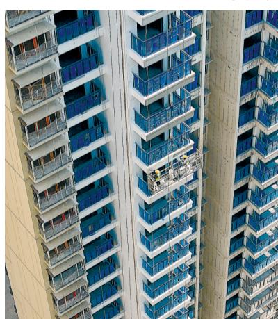
南宁某改造项目施工现场。
