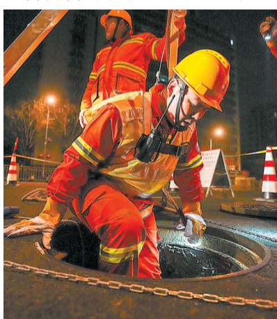
工人进入热力井进行管线巡查。
