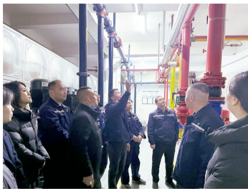
△多方联动现场勘察。
