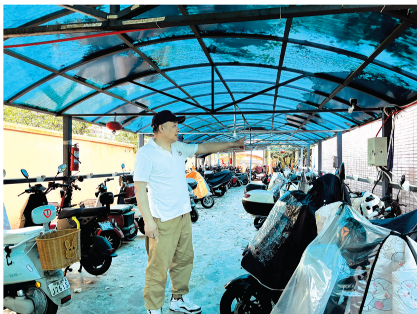
华锦社区春天里小区建起5个电动车棚。
