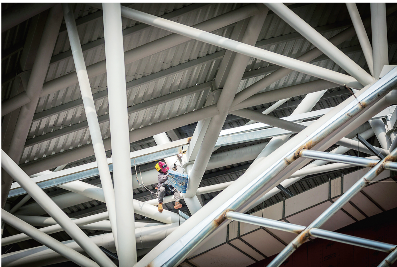
《高空焊影》摄于湖北文体场馆建设现场 作者：赵好(44岁)武昌区黄鹤楼街道彭刘杨社区
