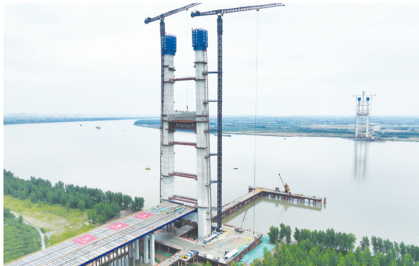
汉南长江大桥两座主塔隔江相望。
