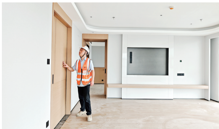
施工中的越秀国际金融汇T4楼酒店客房。 记者宋磊 摄
