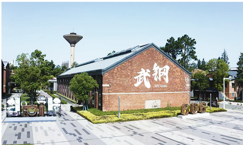
武钢云谷·606产业园将老厂房改造利用,建成现代化园区。
