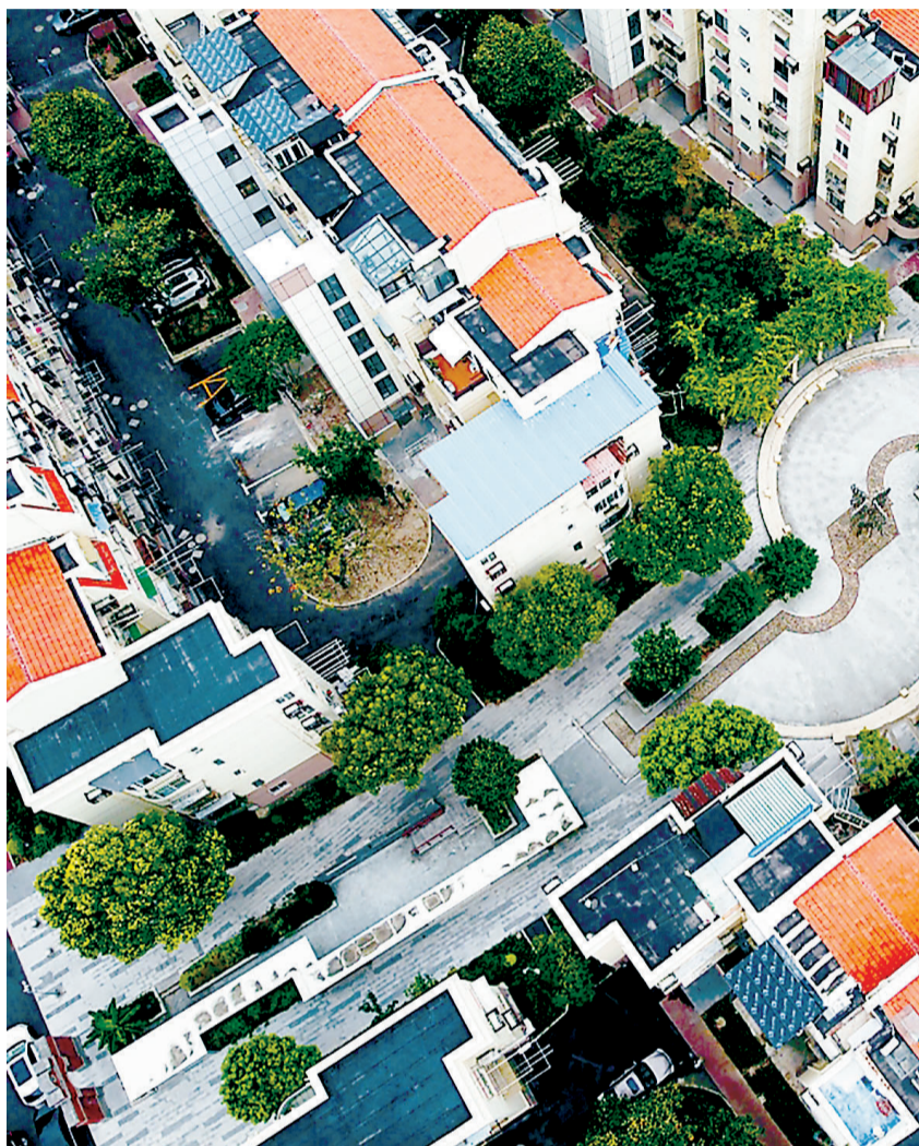
完成综合更新后的上海三林苑小区中轴线。
