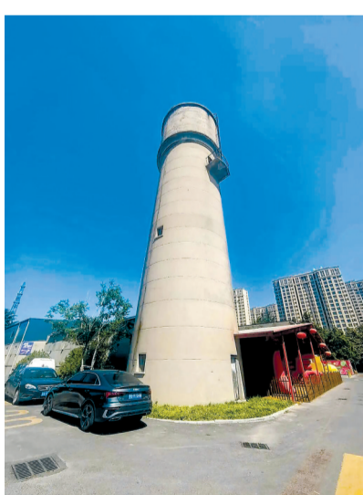
位于园区核心的老水塔。
