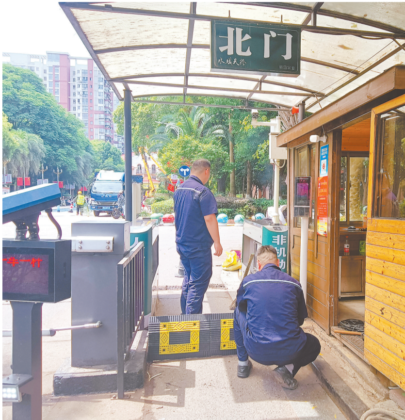
物业公司的工程师傅安装减速板。
