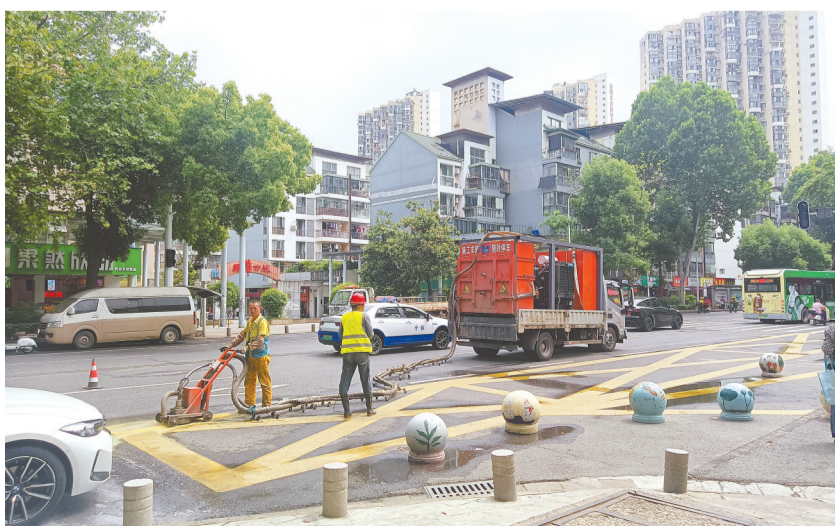
武昌区交警大队派专业人员的小区进出口施划标线。
