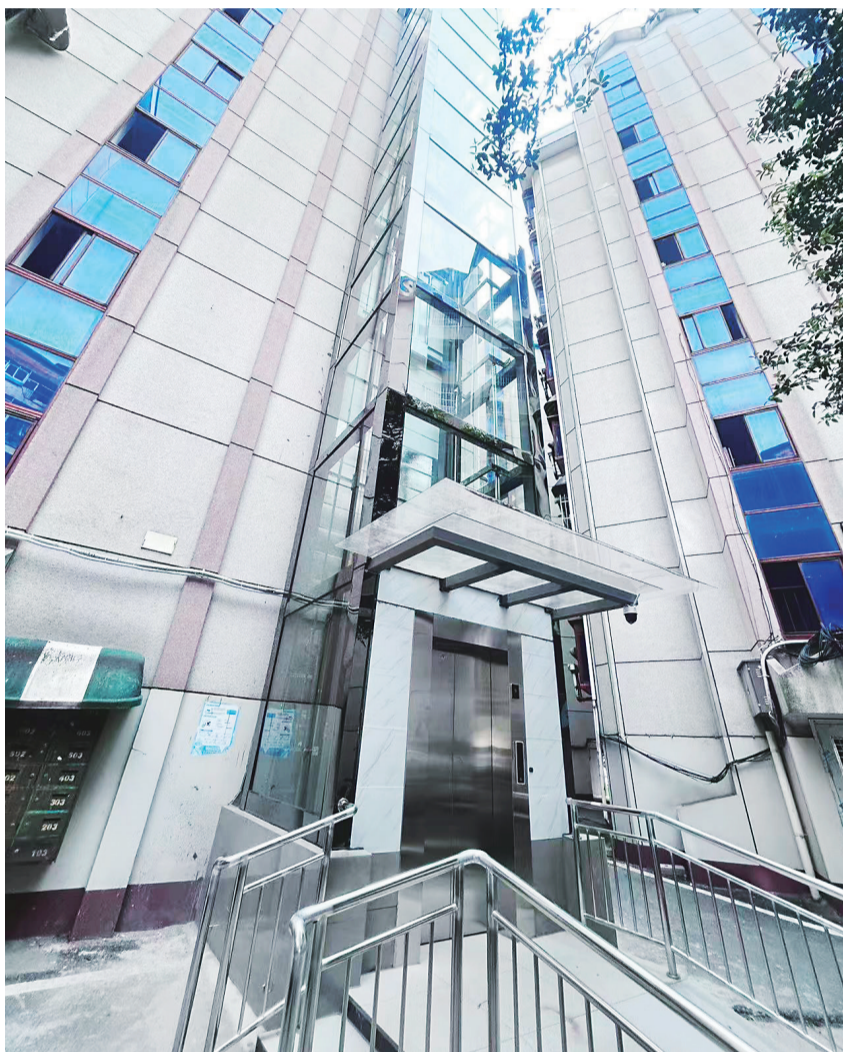
加装电梯投入使用。
