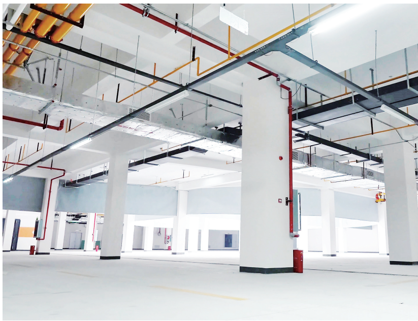
即将竣工的沌口中心广场改造项目内部结构。 经开车谷之声 供图
