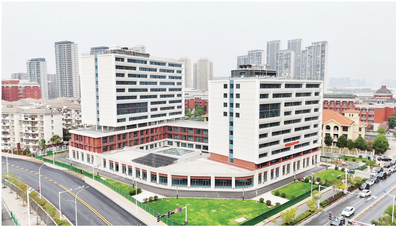
即将竣工的沌口中心广场改造项目。
