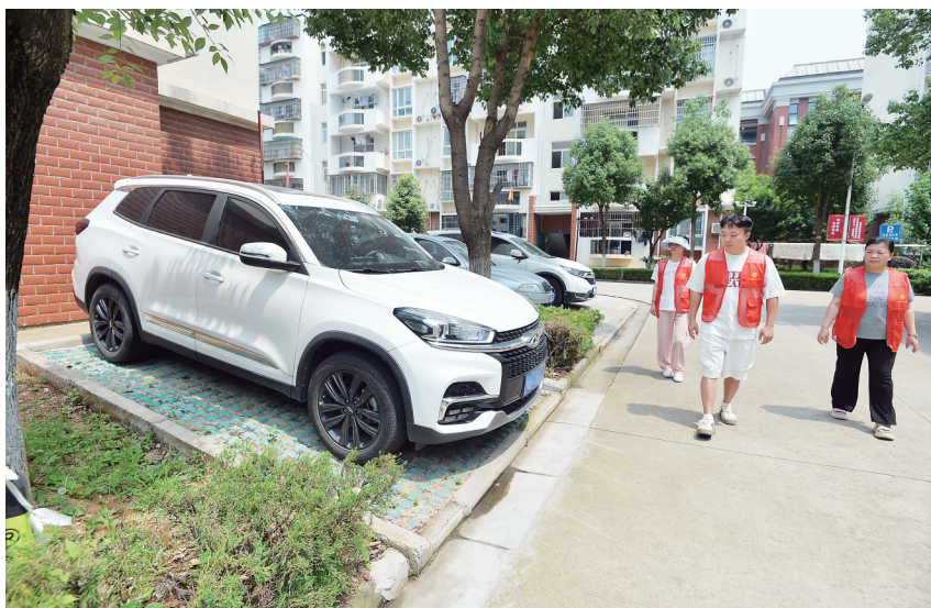
万家湖D区将部分绿化带改造成植草砖铺设地面的车位。
