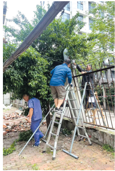
维修工人正在对围墙进行修护。
