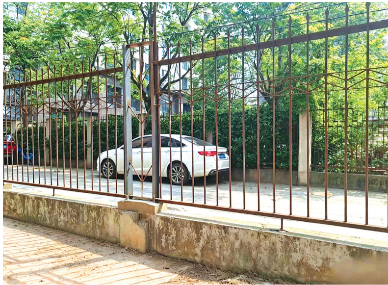
修建完工的围墙。
