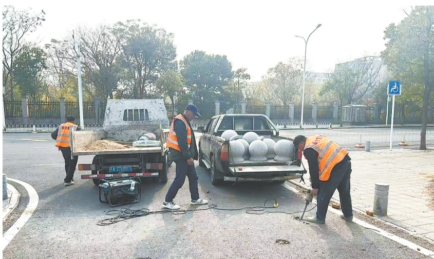
现场施工安装路障。
