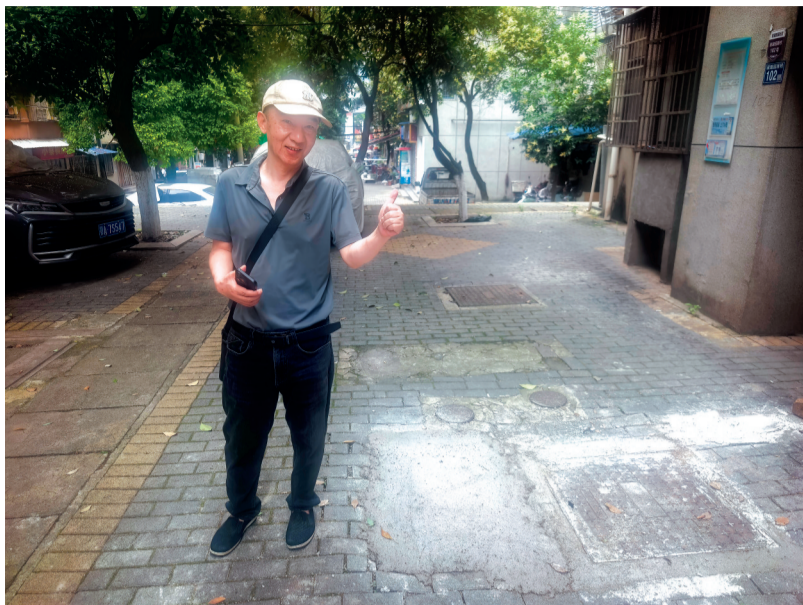
破损塌陷地砖修缮完成,居民吴晶连连称赞。
