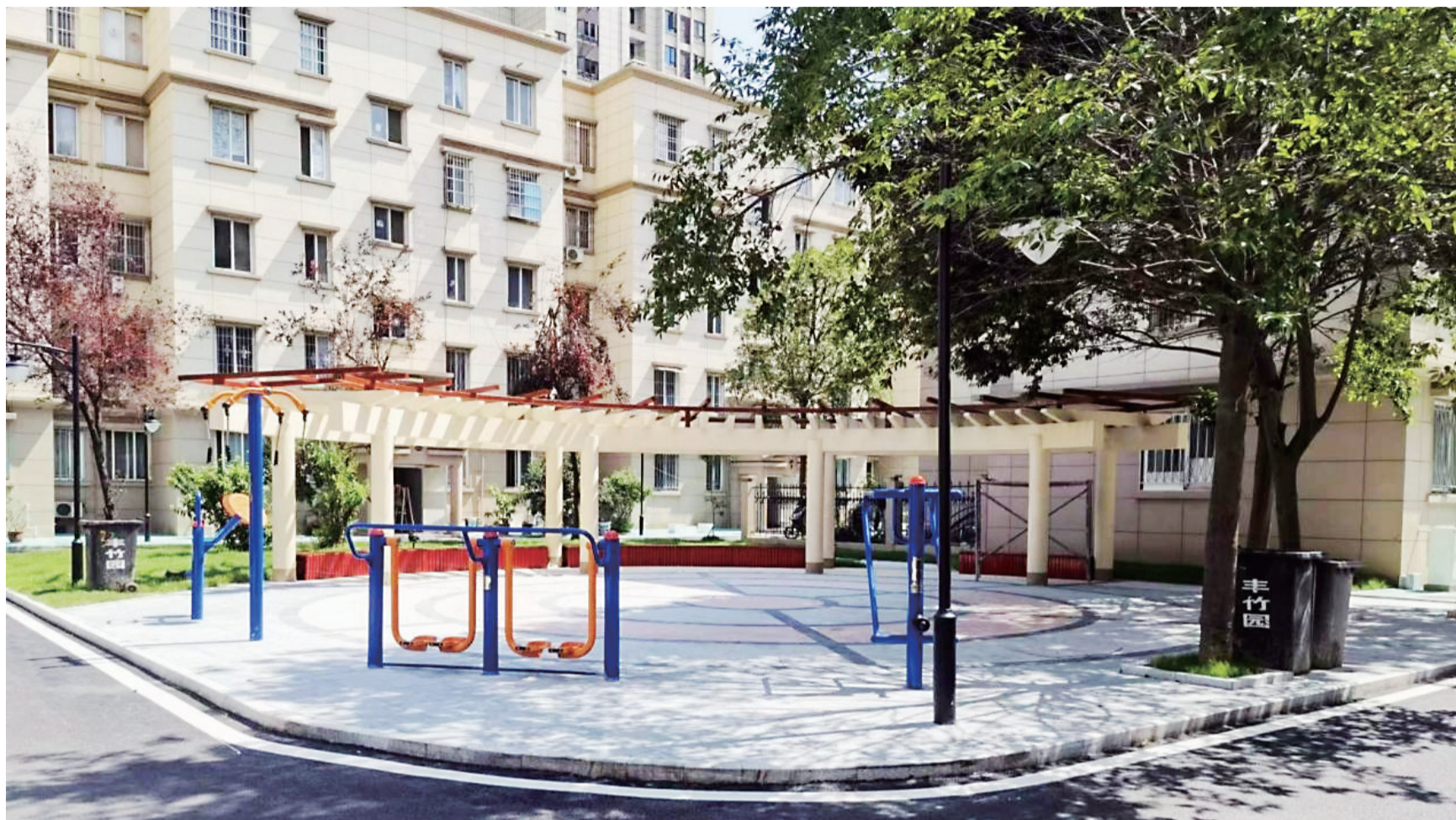
改造后的503广场整洁宽敞。
