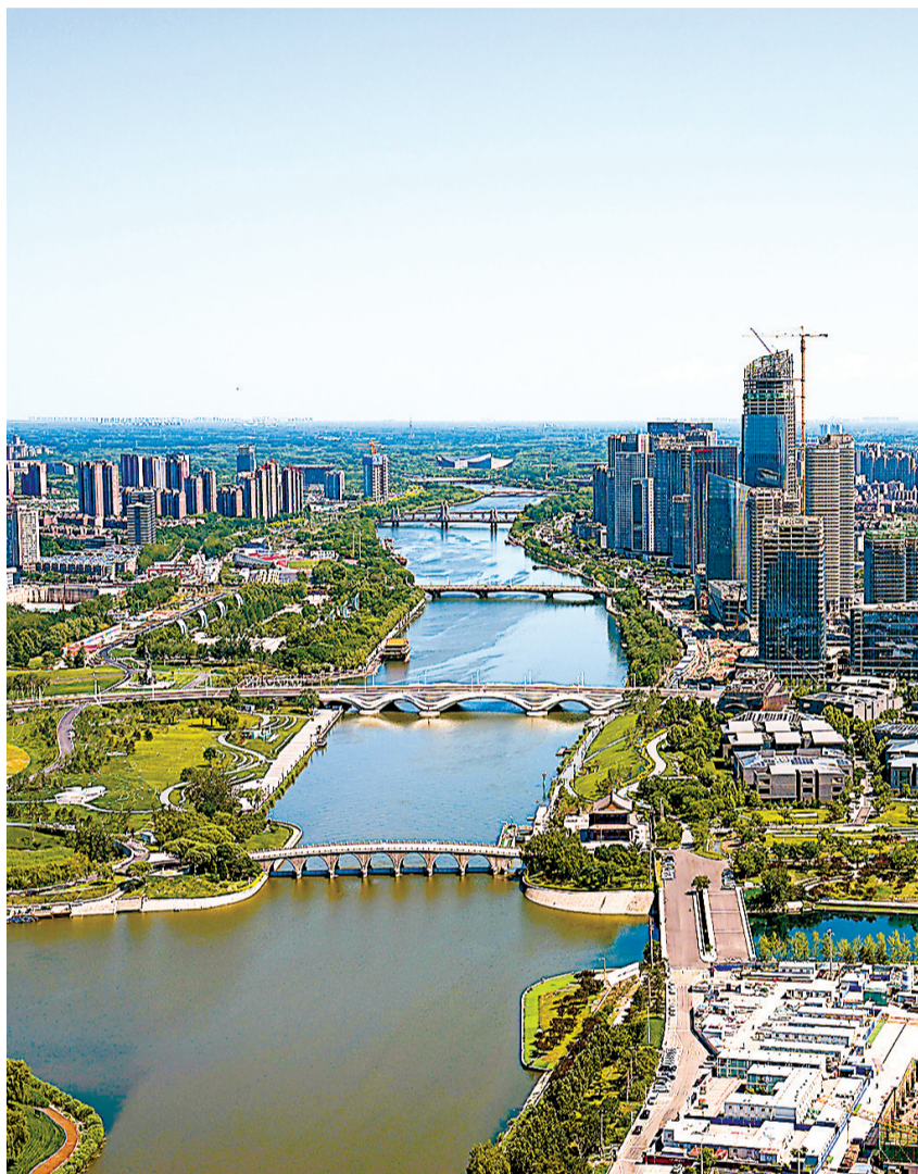
建设中的北京城市副中心运河商务区。
