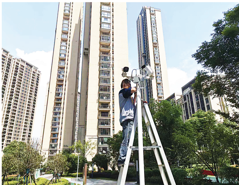
物业工作人员安装高空抛物监控设备。
