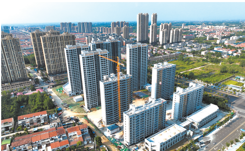
邾城街城东片区棚户区改造项目已初具规模。
