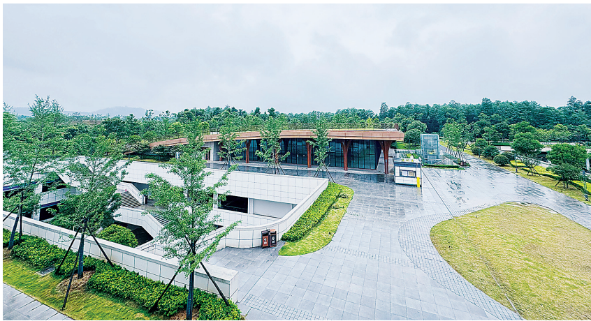
东湖磨山揽翠片区停车项目投用,地上公园、地下停车场。
