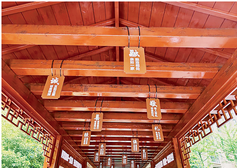
廊亭升级后的内部装饰。
