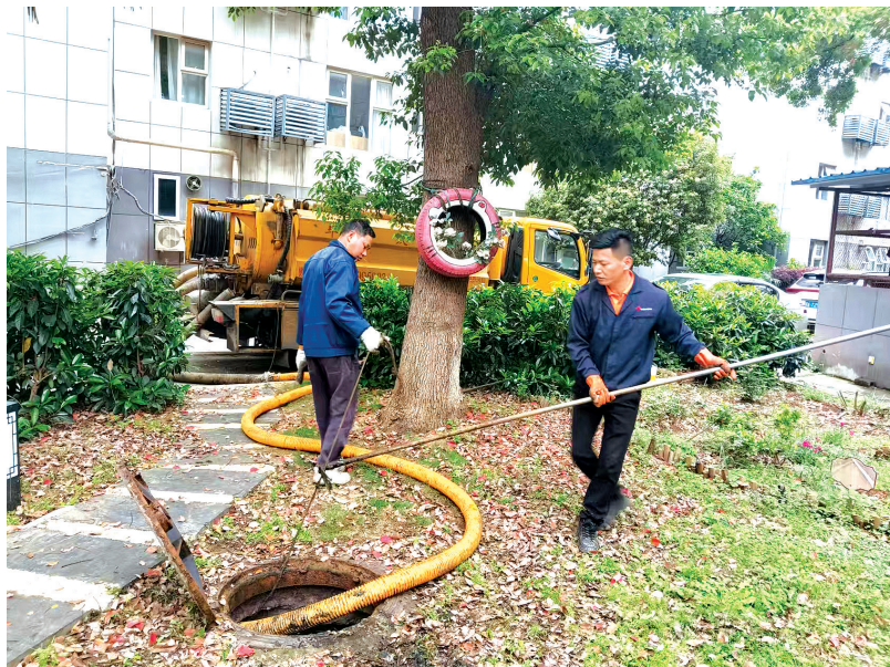
清掏污水管井。
