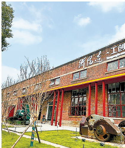
具体改造中,不同车间被赋予全新角色。
