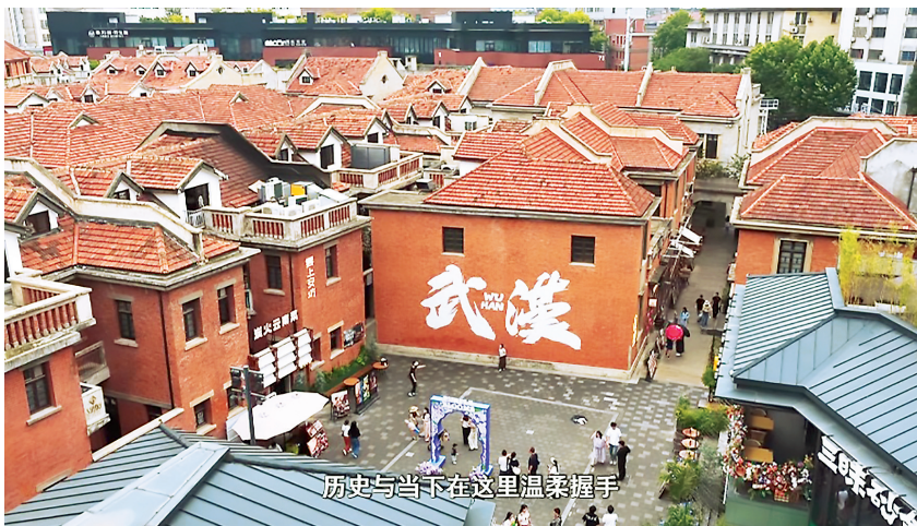
汉口百年咸安坊经过修缮,石库门建筑群重现风华。(视频截图)
