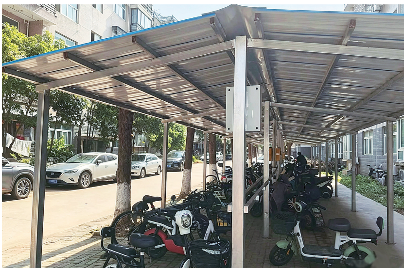
凡谷小区停车棚改造为双边停车棚。
