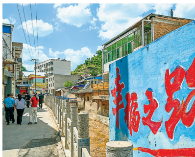
延安宜川县幸福巷“微项目”改造。
