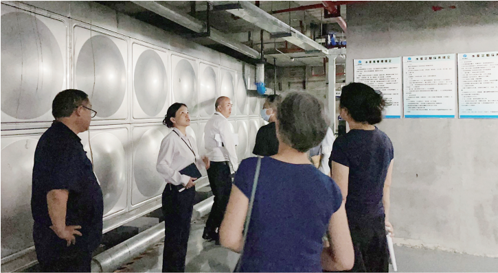
泵房焕然一新。
