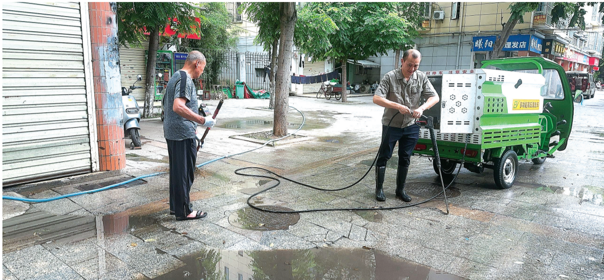
工作人员用高压清洗车清洗路面。
