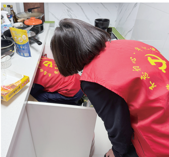
红色管家帮助居民修理水管。
